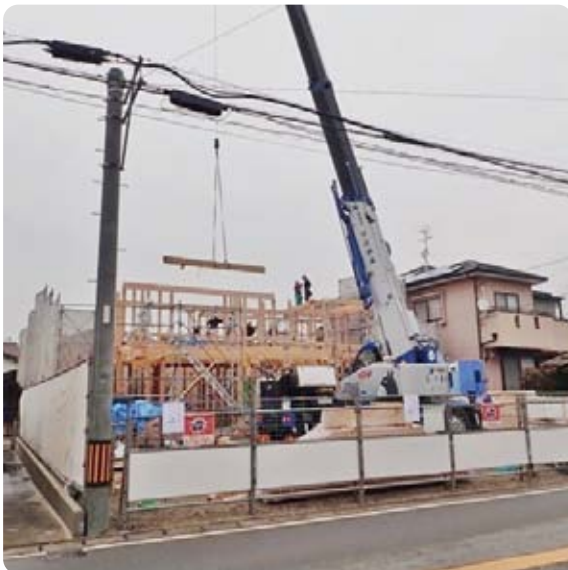
クレーンで棟上げ
